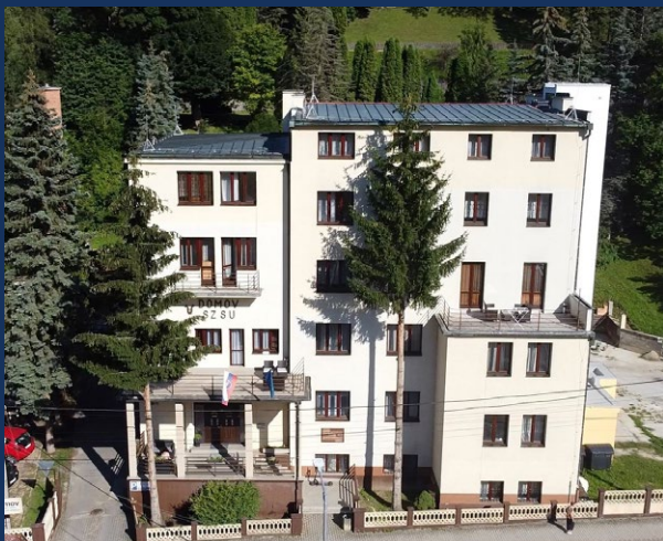
Budova Domova SZSU v Trenčianskych Tepliciach
